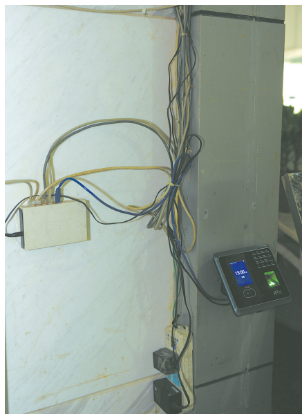
过道内私拉乱接电线现象时有发生
