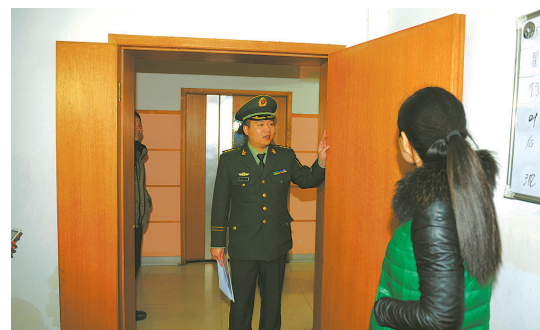
楼梯口未按规定使用常闭式防火门设置封闭楼梯间
