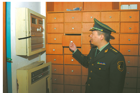
安装消防控制器主机箱的位置未设置独立消控室
