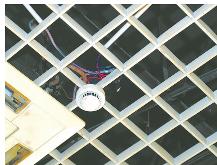
部分烟感探测器设置不符合要求
