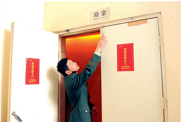
常闭门上的闭门器被一根插销替代
