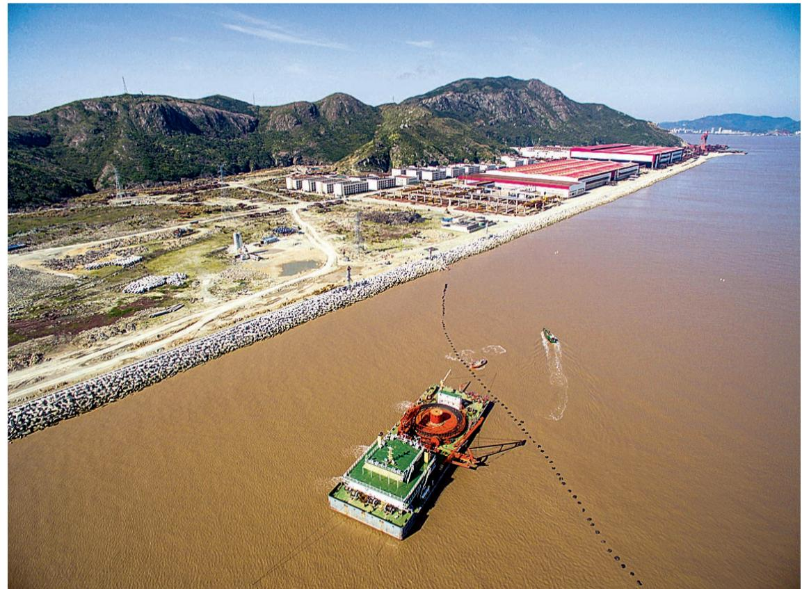
4月19日，敷设海缆的施工船到达距离终点1公里左右的海域，最后一段海缆被套上一个个充气轮胎，通过牵引缓缓登陆上岸。
