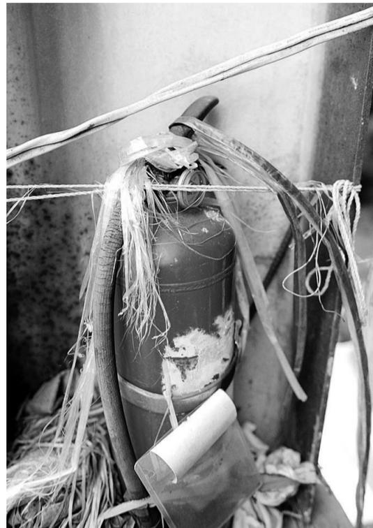
灭火器的橡胶管已经老化破损
