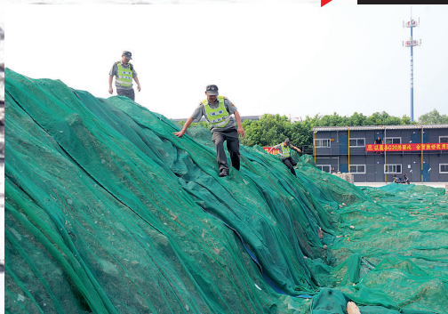
巡查建筑工地上裸露的土方是否用网覆盖
