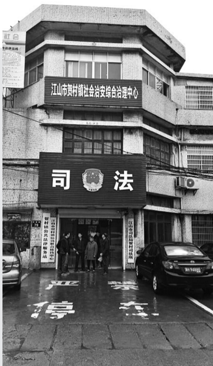
贺村镇社会治安综合治理中心
