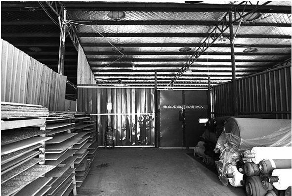
车间之间使用彩钢瓦进行隔造
