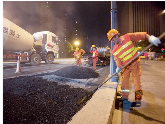
摊铺沥青,一弯腰,热气烫脸。
