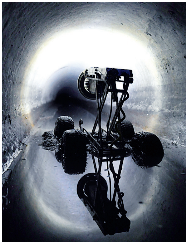
机器人深入管道进行检测
