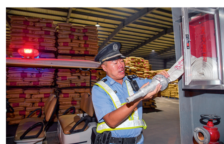
程武强仔细检查每个仓库的消防设施
