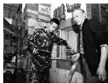
章一立检查消防栓水压情况
