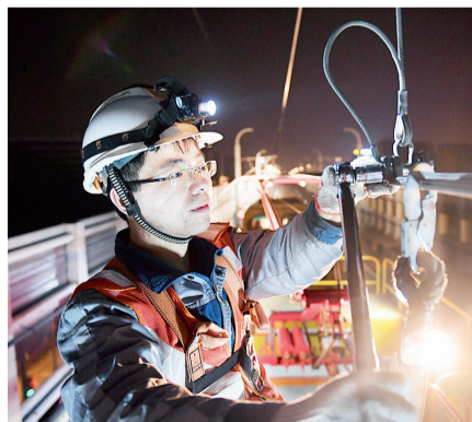
仔细检查接触网上的吊弦
