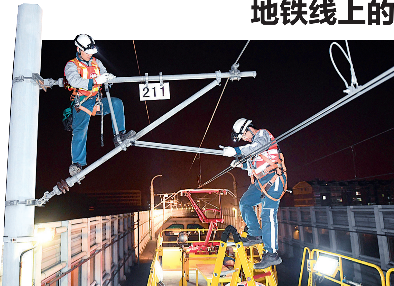
站在腕臂上进行维护作业
