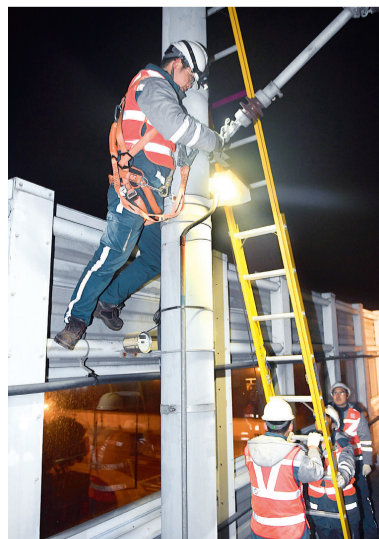
对接触网支柱进行维护
