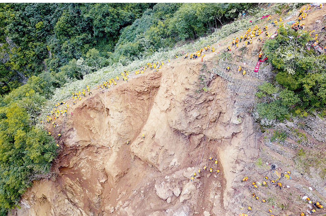
7月18日,抢险人员在宝成铁路陕西略阳县王家沱至乐素河区间山体崩塌现场清理松动土石(无人机拍摄)。 目前,宝成铁路陕西略阳县王家沱至乐素河区间山体崩塌抢险工作仍在紧张进行。自水害发生后,现场多次发生强降雨,坍塌坡面地质情况不断发生变化,严重影响抢险工作。 新华社 唐振江 摄
