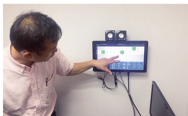
油气回收自动监测系统
