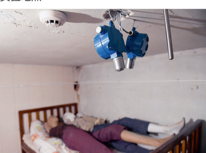
现场设置了多样检测仪器
