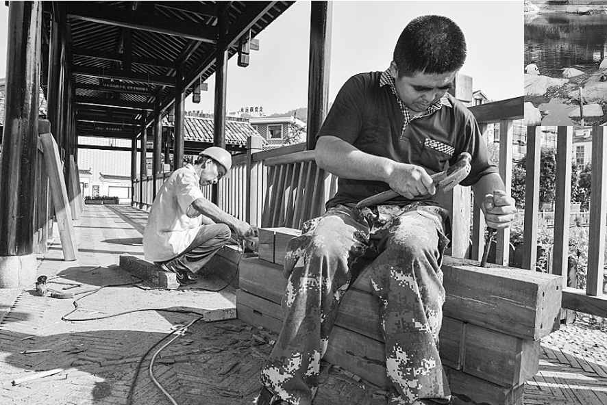
8月9日,淳安县下姜村村民正在整修村里的一座廊桥。他们除了对桥墩进行加固外,还将桥上有腐烂迹象的木制围栏全部更换,排除安全隐患,确保村民和游客的安全。 董旭明 刘健 摄
