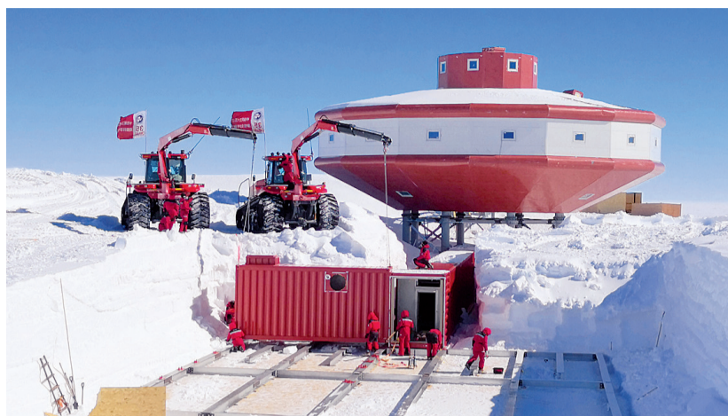
科考队员正在建设我国首个南极雪下工程
