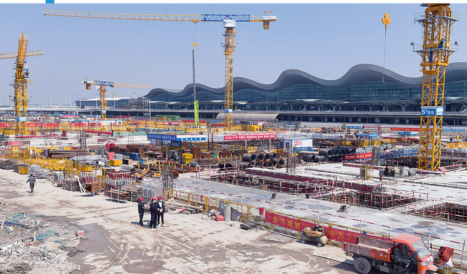
民警在建筑工地作业区开展安全检查,指导项目部落实疫情防控主体责任
