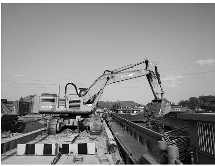
水路中转码头上挖掘机正在将渣土装船
