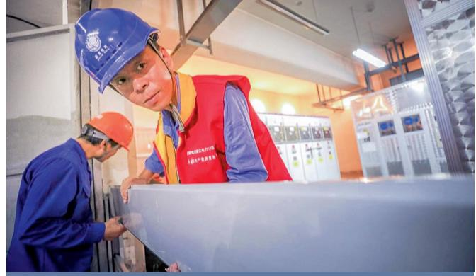
↑ 9月13日一早，宁波市海曙供电公司工作人员，在乡镇配电房安装防水挡板，防止电路短路，影响居民用电。据悉，当地在洞桥镇、古林镇、高桥镇、集士港镇等8个乡镇、70余个配电房安装了全封闭、高1米的防水挡板。
