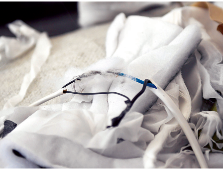
私拉乱接的电气线路
