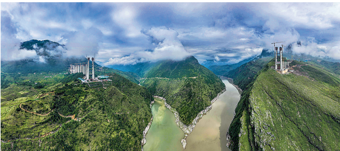
6月9日拍摄的正在建设中的纳晴高速公路牂牁江特大桥(无人机全景照片)。
