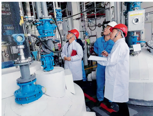
2022年5月,全市开展“百日除百患”专项行动。市应急管理局对危化生产企业开展安全检查。
