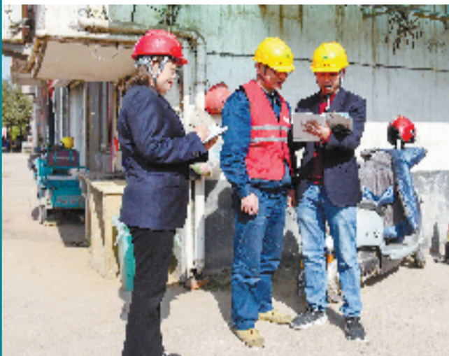
国网武义县供电公司壶山供电所支部纪检委员深入浙江武义凯伦工贸有限公司业扩验收现场,对供电公司服务企业廉政风险点开展监督检查。
