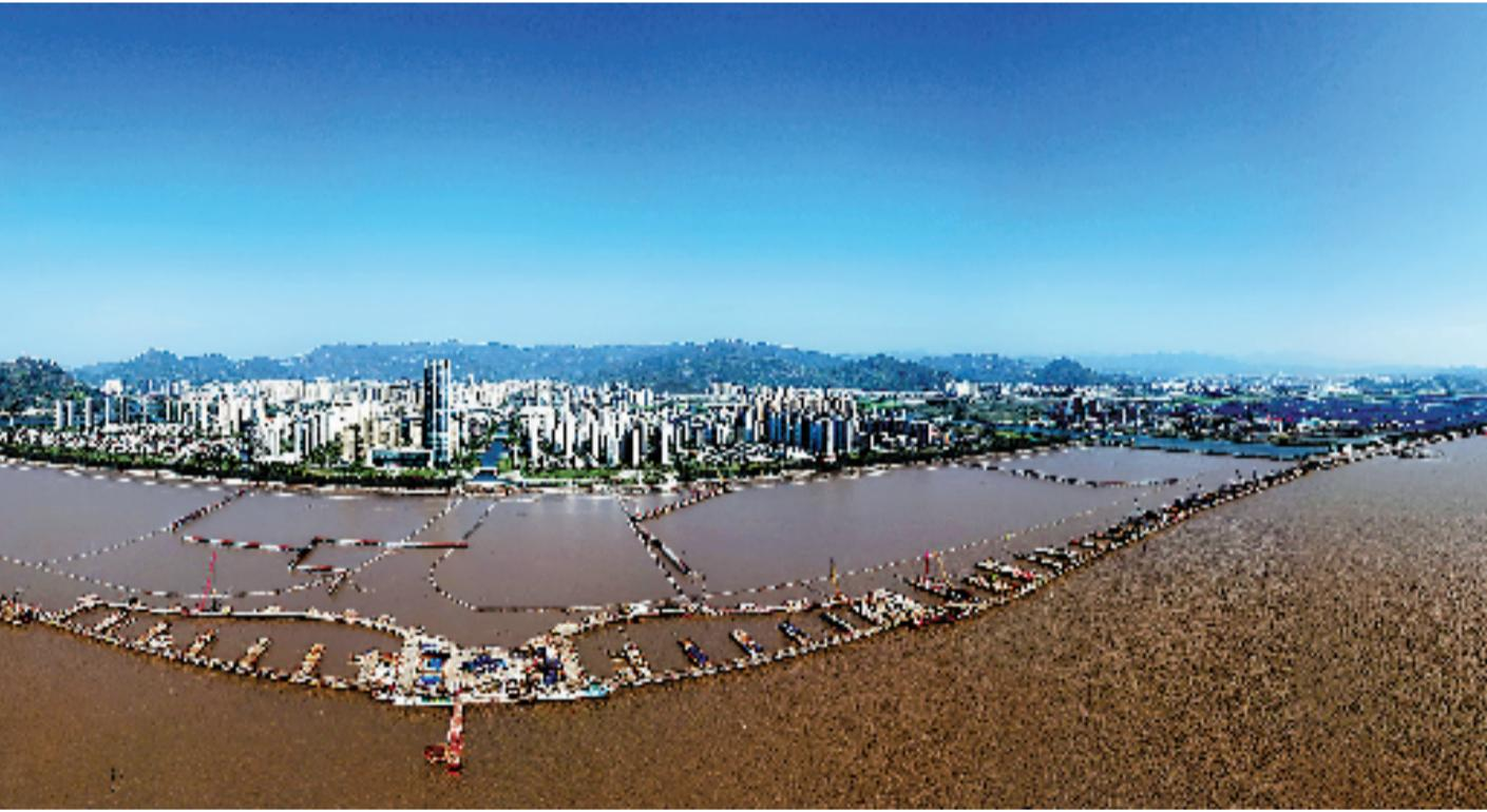
4月9日，乐清市滨海大道桥梁项目正进行桥梁打桩、浇筑桥墩等施工。该项目工程采用一级公路兼顾城市道路功能技术标准，其中乐清湾沿海滩涂区域采用“桥堤结合”、跨越海涂造桥方案，加强沿海滩涂的开发利用和生态环境保护。
