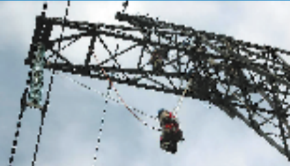
蒋卫东应用首创的绝缘“土字梯”荡入法等电位法开展作业 陈攀 摄
