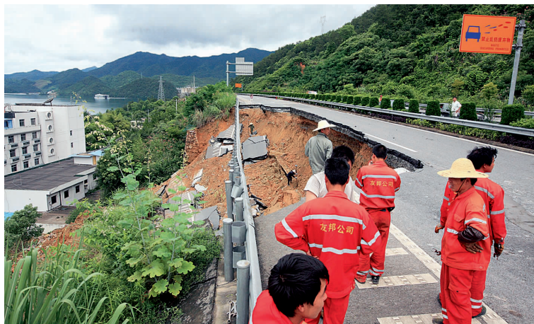
养护工人在现场维护
