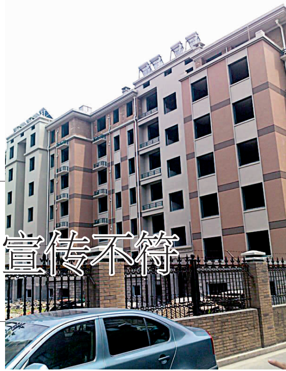
星河苑两幢外立面用涂料的房屋
