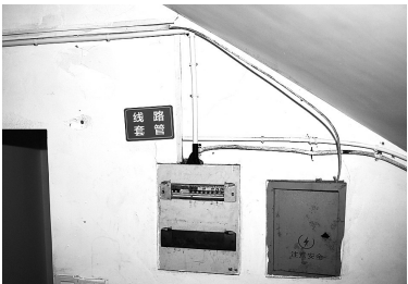
出租房内的线路进行套管处理
