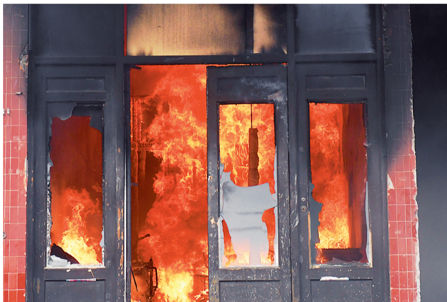
一楼起火客厅猛烈燃烧
