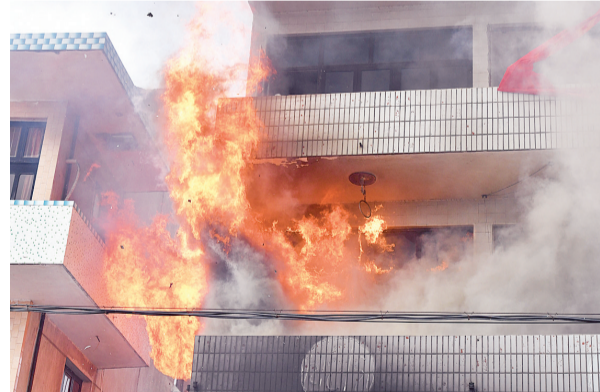
二楼南侧房间发生轰燃
