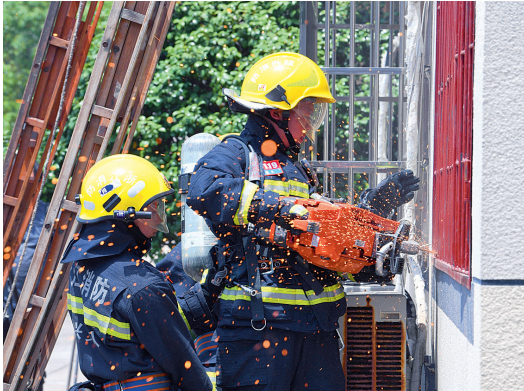
用无齿锯破拆防盗窗
