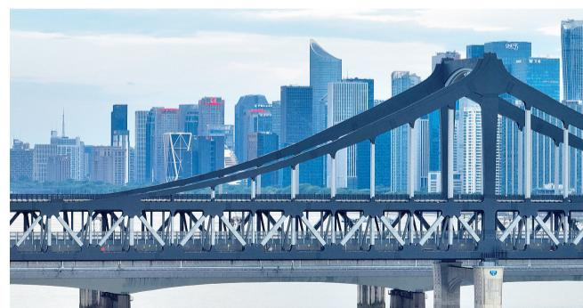
9月28日上午10点,新彭埠大桥开通。作为国内首座多跨长联公轨两用悬链形上加劲钢桁梁桥,项目关键节点工程——新建彭埠大桥全长1350.8米,分上下两层,上层为8车道高架快速路,下层为双线快轨,杭州地铁首次实现“踏浪飞渡”。值得一提的是,新彭埠大桥设置慢行系统,行人可以在慢行道上体会钱塘江的壮阔和两岸的风景。
