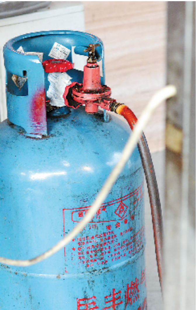
橡胶软管积满油渍
