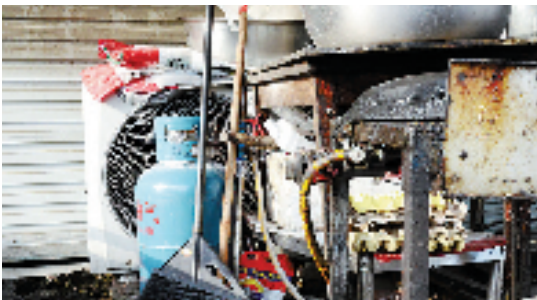
液化气瓶放在空调外机出口位置
