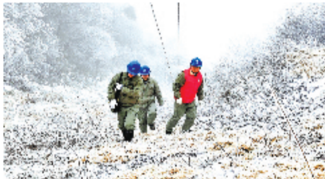
2月3日,在湖北宜昌长阳县火烧坪乡,国网宜昌供电公司工作人员在巡查覆冰线路。
