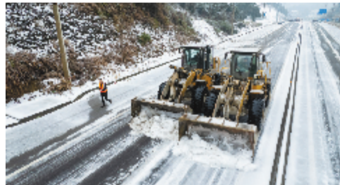
2月5日,在位于湖南省益阳市桃江县境内的S230桃江段,桃江县公路局工作人员调用除冰车铲除道路上的冰雪(无人机照片)。
